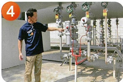
4 緊急遮断装置の仕組み説明
