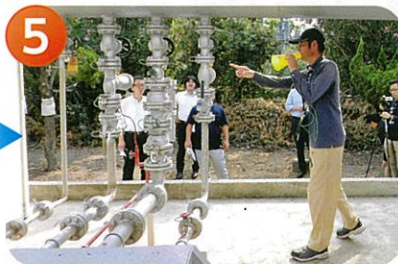
5 配管の確認(損傷があるかないか)
